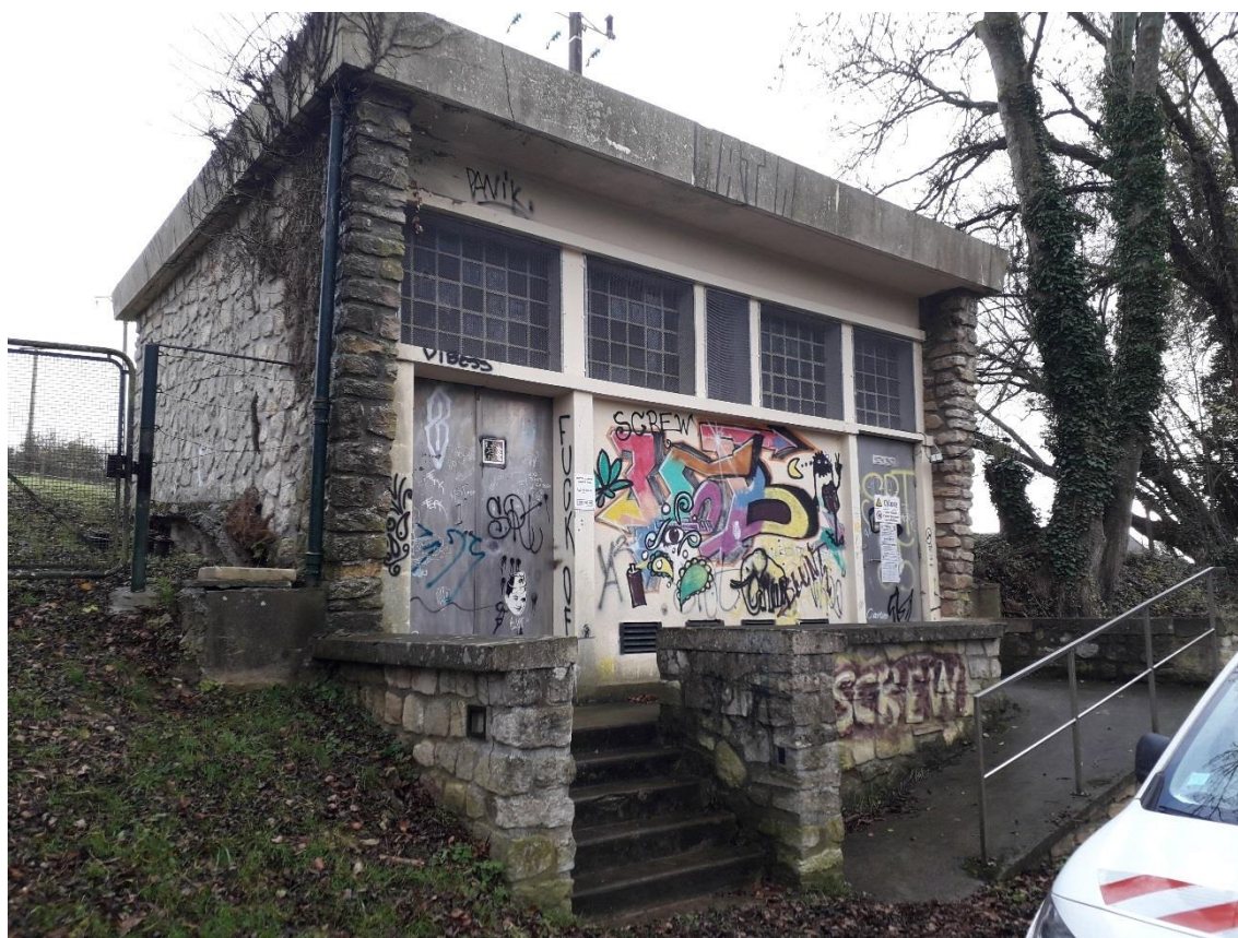
Figure 8 : Partie avant du bâtiment d'exploitation
