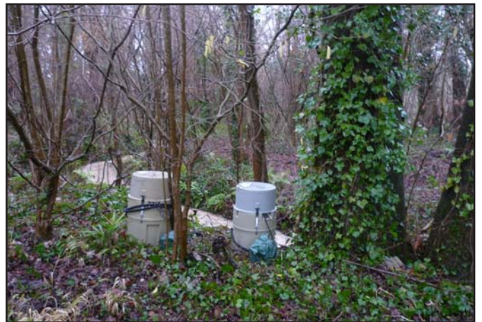
Photographie 4 : Préleveurs automatiques sur le ruisseau de l'Eau Brillante, juste en aval du rejet du trop plein de la source de l'Eau Brillante
