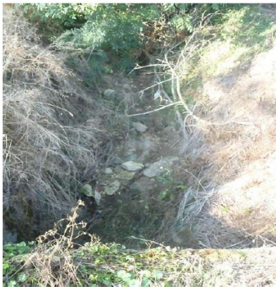
Photo 1 : fossé au niveau de la route
