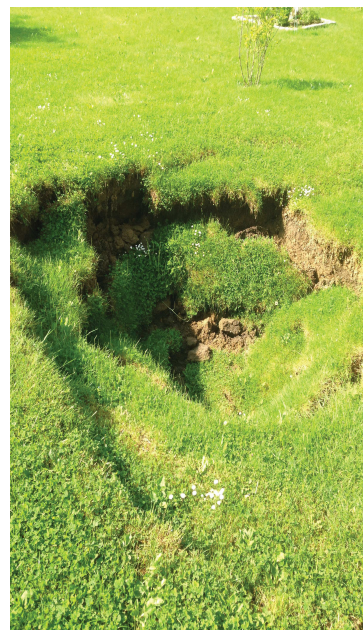
Illustration 7 : effondrement par fontis au 43 rue du château d'eau – Saint-Rémy-lès-Chevreuse -2016.
